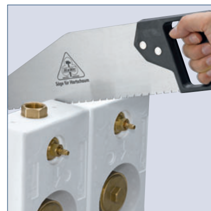
Trennung des Montageblocks (zum Singleblock) mit handelsüblicher Säge
